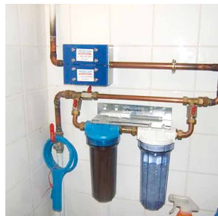
Le traitement de l'eau par rayons UV permet de réduire significativement la contamination de l'eau, sauf en cas de défaut d'installation ou d'entretien
