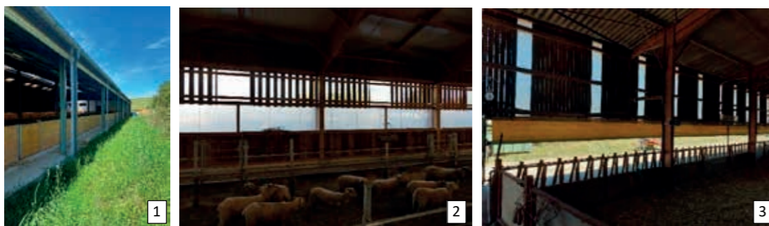
Photo 1 : rideau enroulable, crédit photo Morgane Lambert Photo 2 : bardage à claire-voies coulissant, crédit photo Eliette Karche Photo 3 : bardage à claire-voies fixe et rideau enroulable en partie basse, crédit photo Marine Gicquelet-Gorre Photo 4 : rideau ascenseur translucide, crédit photo Christophe Béalu
