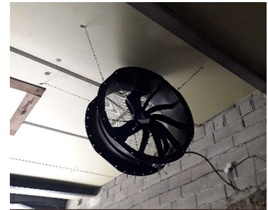
Photo 5 : Brasseur à flux horizontal, crédit photo Pierre Mahistre
